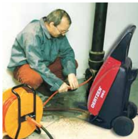
31er in der Gebäudetechnik: Hochdruck-Rohrreinigung - einfach und effektiv
